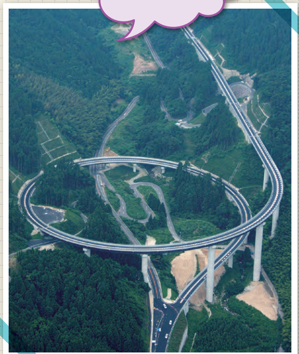
福岡/三瀬トンネル
